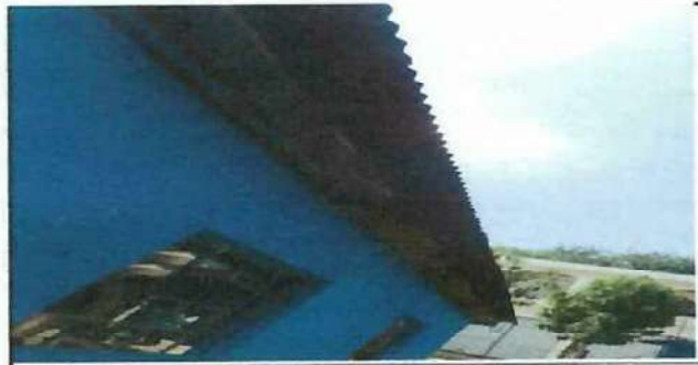
Foto 6: Instalación de canales y bajadas pluviales, instalacion de canales y bajadas para las aulas.
